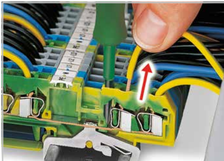
Извлечение проводника при помощи монтажного инструмента.
