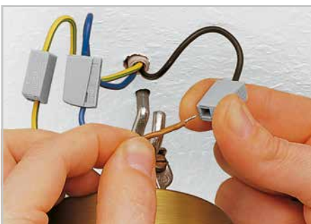
Страна осветительной арматуры: нажмите до упора кнопку, введите в прямоугольное отверстие конец зачищенного проводника и отпустите его.
