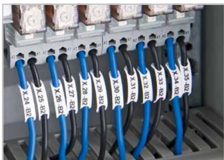
Маркеры с отверстиями для продевания проводника
