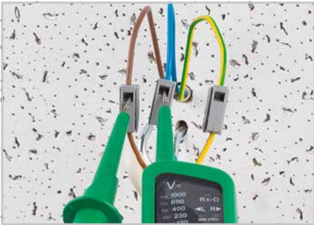
Измерение напряжения через отдельные тестовые гнезда.
