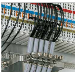
Установка на U-образной медной силовой шине
