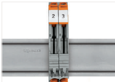
Подготовка для цепей трансформатора тока.
