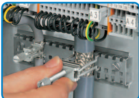
Добавление экранирующей зажимной скобы.
