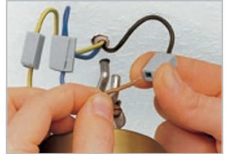
Отключение: нажать кнопку и извлечь проводник.
