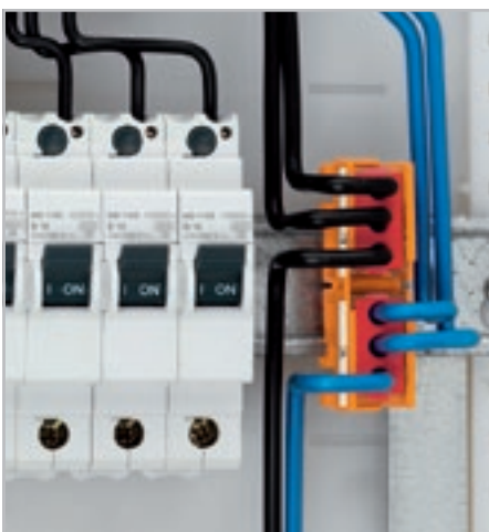
Подключение одножильных и многожильных проводников 6 мм²/AWG 10.
