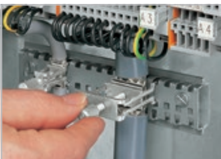
Затяжка/удаление зажима для экрана.
