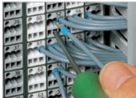
Подключение проводников с наконечниками.
