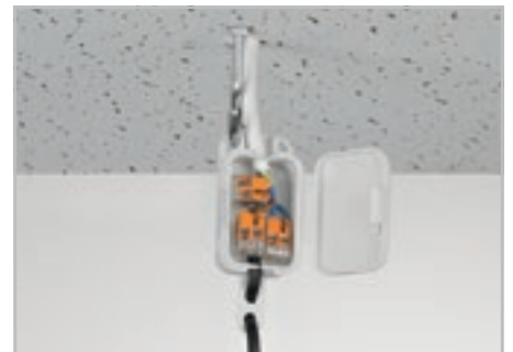
Подвесное присоединение светильников в подвесных потолках
