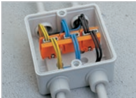
ЗАФИКСИРОВАННОЕ ПОЛОЖЕНИЕ - винтовое крепление
