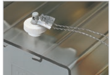
Крышка с пломбой. При использовании крышек без пломб возможно повреждение винтового купола.
