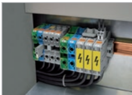
Боковое подключение означает, что даже большие проводники с ограниченной гибкостью могут быть легко подключены.
