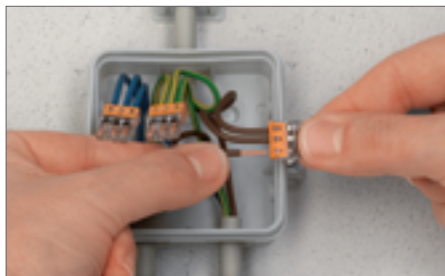
Соединение PUSH WIRE®
