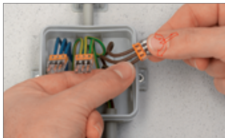
Соединение PUSH WIRE®
